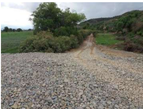
FOTOGRAFIA N° 11 INTERSECCION CON CAMINO CON RIPIO PROG. 2+620 MARGEN SUD
