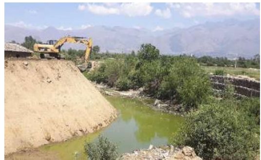
FOTOGRAFIA N° 12 ESPARCIMIENTO DE RIPIO PROG. 4+180 MARGEN SUD
