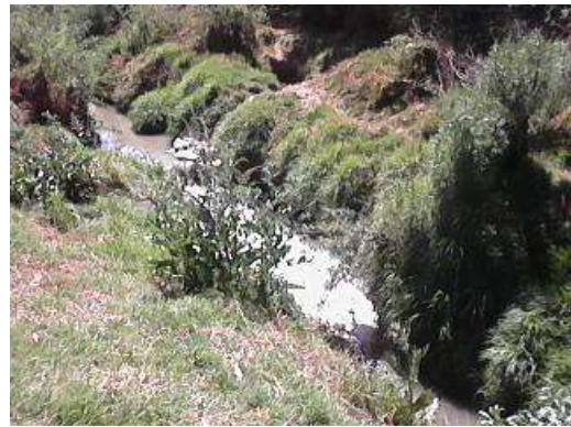
FOTOGRAFIA N° 8 EQUIPO TRABAJANDO PROG.2+860 MARGEN SUD
