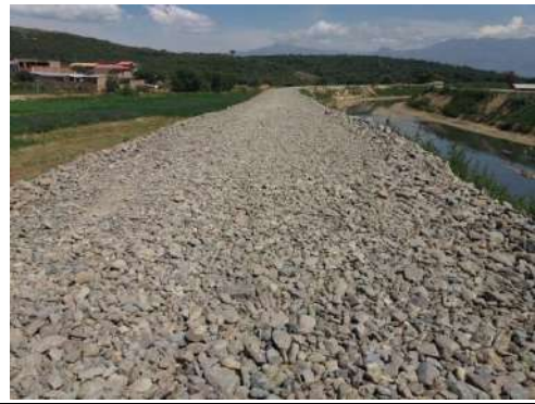
FOTOGRAFIA N° 10 PLATAFORMA CON RIPIO PROG2+560 ADELANTE MARGEN NORTE
