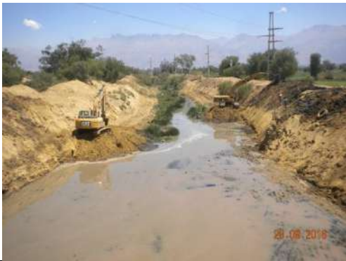
FOTOGRAFIA N° 9 COMPACTADO PLATAFORMA PROG. 2+560 A 2+900 NARGEN NORTE
